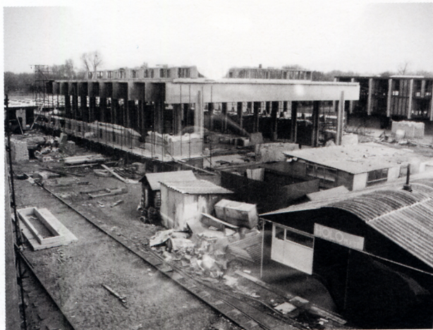
Le hall en chantier, révélant le système singulier colonnes + poutres.
