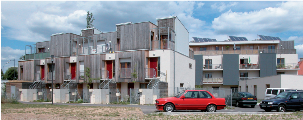
1. A gauche, les logements intermédiaires B1. A droite, le petit collectif A1 couronné de panneaux solaires pour l'eau chaude sanitaire.
